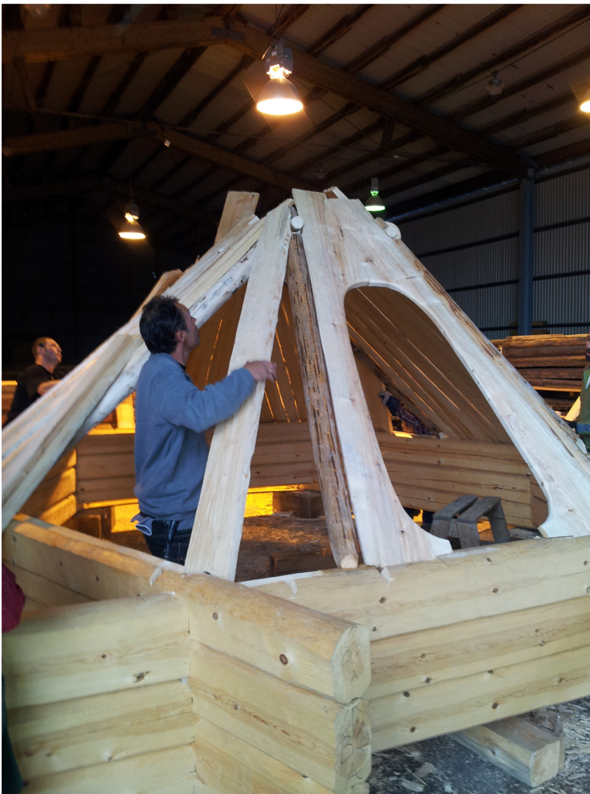
Rekonstruktion av en sexkantig timmerkåta, en numera nästan bortglömd samisk byggnadstyp. Foto Kjell-Åke Aronsson
