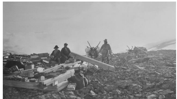
Bärare med byggnadsmaterial till forskningshydda
